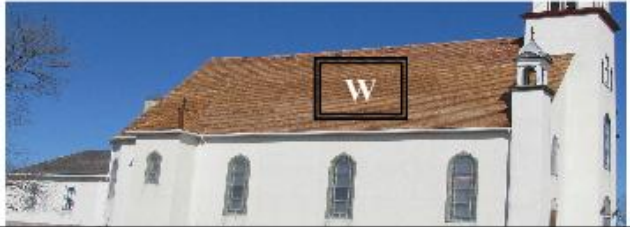
Côté ouest du toit ~ Réparations complétées le 12 avril 2011, merci pour les donations! West side of the roof ~ Repairs completed April 12, 2011, Thank you for the donations!
