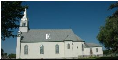
Côté est du toit ~ East side of the roof
